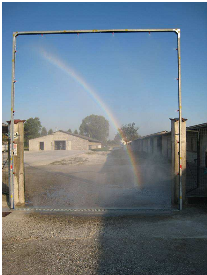
Arco disinfezione in funzione 1
