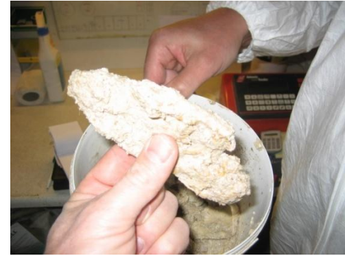
Biofilm e sedimentazione nei tubi
